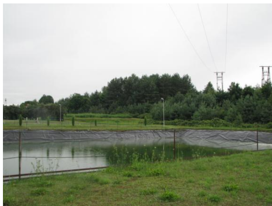
Fot 2. – Oczyszczalnia ścieków w Biesalu (Zdjęcie własne wykonane podczas wizji w terenie).
